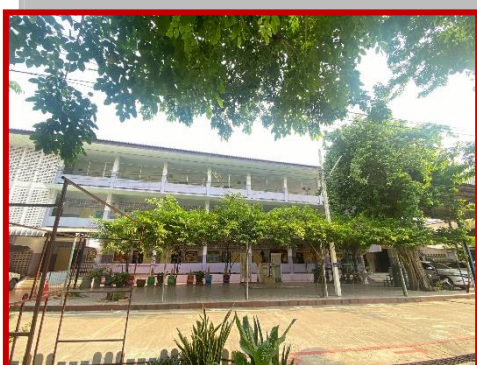
อาคารสีม่วง ห้องเรียนระดับชั้นประถมศึกษาปีที่ ๓ ห้องเรียนโครงการ MEP, ห้องธุรการ, ห้องผู้บริหาร, ห้องบริหารงานวิชาการ, ห้องฝ่ายบริหารทั่วไป, ห้องบริหารงานงบประมาณ, ห้องบริหารงานบุคคล
